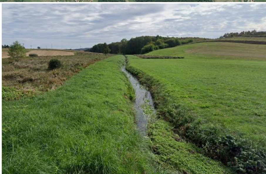
Slika 4.1-1. Lokacija planirane retencije Vuj na potoku Vuj, pogled uzvodno s polovine retencije (gornja slika), pogled nizvodno s polovine retencije (donja slika)
