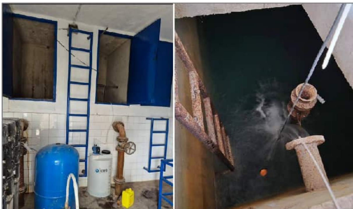
Slika 13. Revizijska okna vodospreme i ulaz vode u vodospremu od izvorišta (Izvor: Hidrološki elaborat, IDT d.o.o., Osijek, travanj 2026.)
