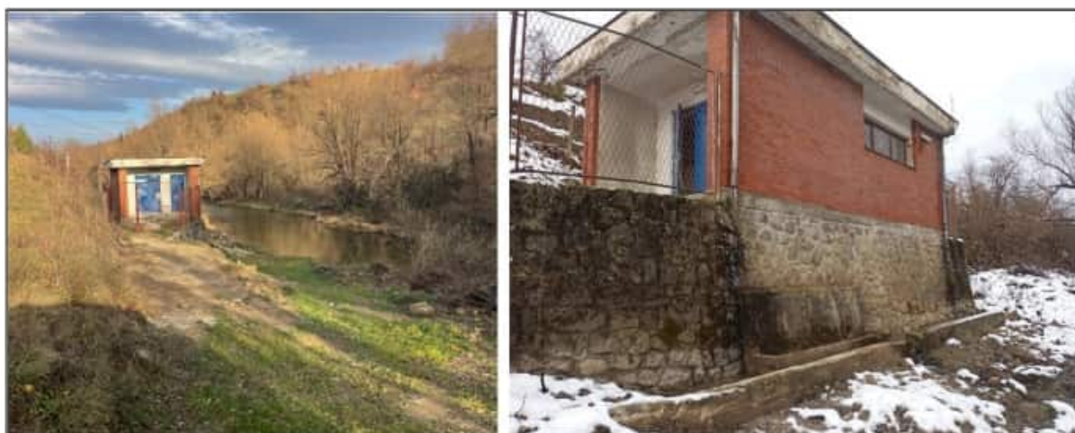
Slika 36. Objekt vodocrpilišta (izvorište Gavranić Vrelo)
