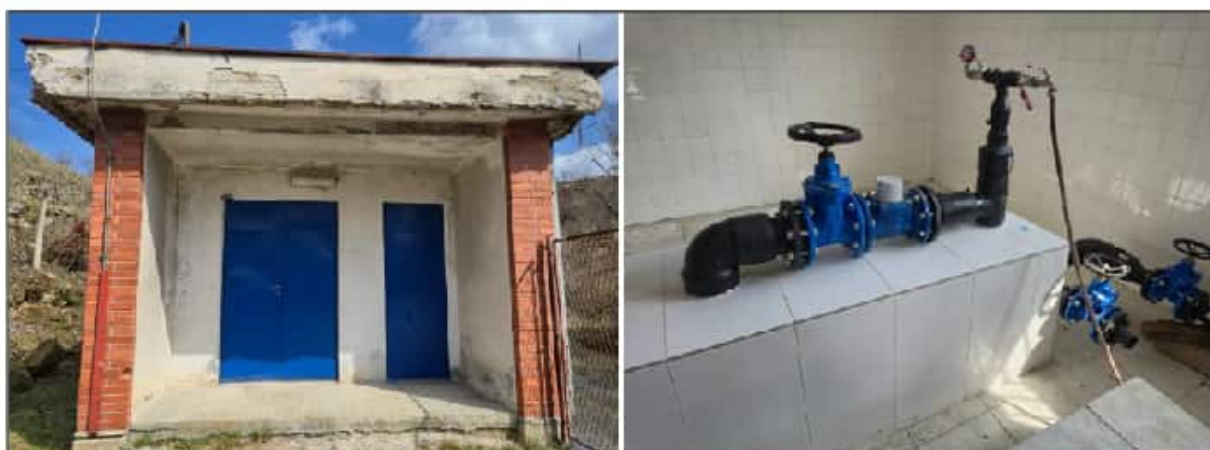
Slika 3. Objekt izvorišta i unutrašnjost (cjevovod od bazena prema farmi) (Izvor: Hidrološki elaborat, IDT d.o.o., Osijek, travanj 2026.)
