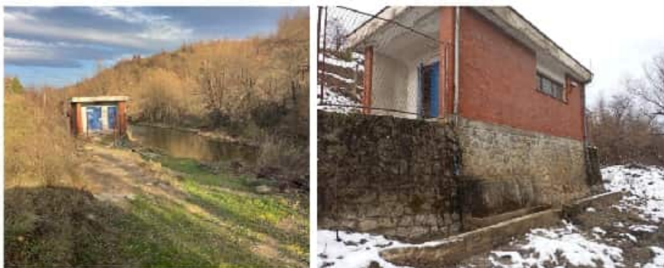
Slika 15 Prilaz objektu izvorišta i prelivnu na bočnoj strani prema Korani
