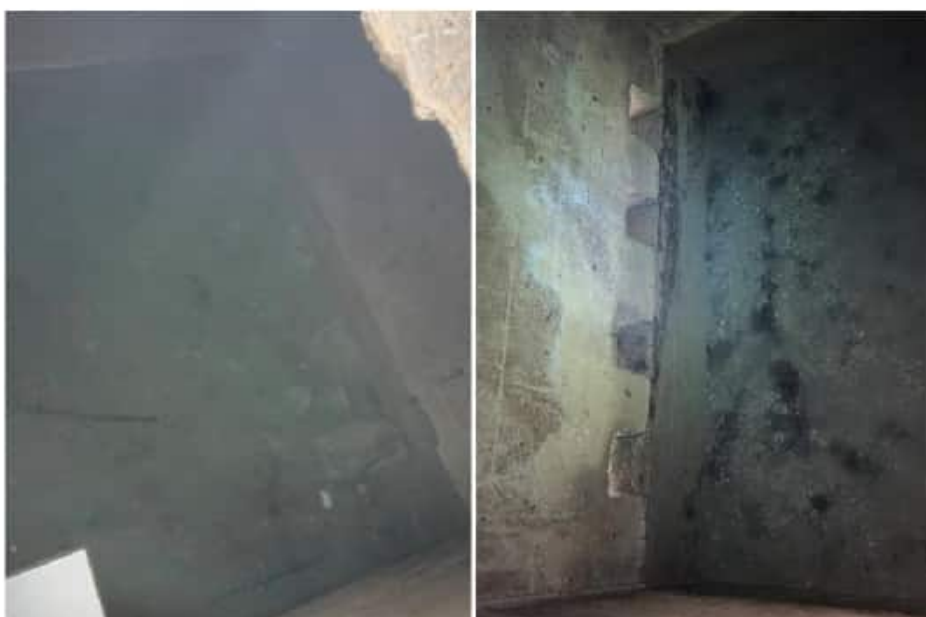
Slika 14 Izvor vode iz stijene u objekt kaptaze (lijeva slika) i prorori za istjecanje vode u Karanu (desna slika)
