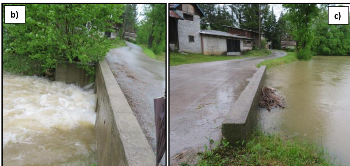
Slika 2.1-6. Postojeći cestovni propust izveden na nerazvrstanoj cesti u predjelu Gerovci (istočno od područja zahvata): za vrijeme sušnog razdoblja (a; izvor: Google Maps, 2025.) i za vrijeme poplave (b, c; izvor: Geokon d.o.o., 2025.)
