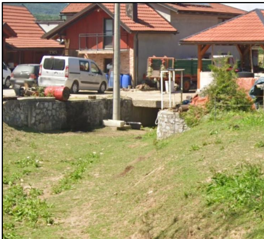
Slika 2.1-5. Postojeći cestovni propust izveden na k.č. 1240/3 k.o. Zagorje za propuštanje potoka Bojana (snimljeno za vrijeme sušnog razdoblja) (izvor: Google Maps, 2025.)
