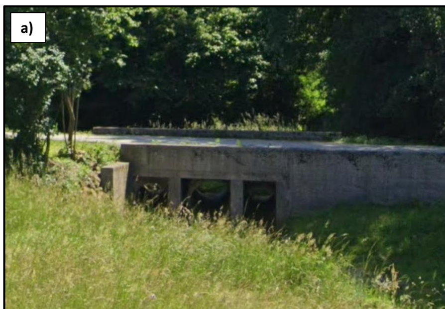
Slika 2.1-5. Postojeći cestovni propust izveden na k.č. 1240/3 k.o. Zagorje za propuštanje potoka Bojana (snimljeno za vrijeme sušnog razdoblja) (izvor: Google Maps, 2025.)
