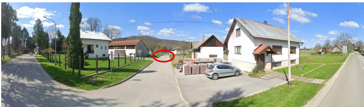
Sl. 3.9-3. Lokacija planiranog zahvata označena na umanjenoj panoramskoj fotografiji (pogled na zapad s najbliže točke na Ogulinskoj ulici)
